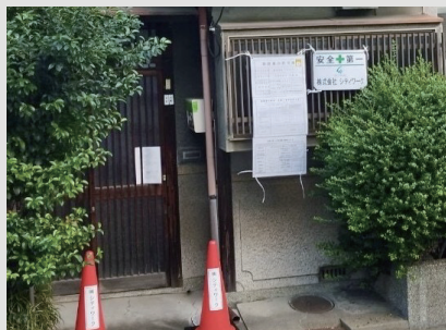
工事内容と近隣への注意書きの掲示
